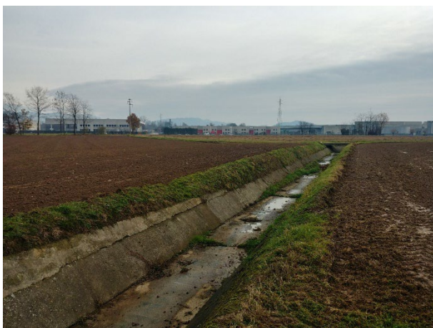
Fotografia 3: Ramo est visto dal partitore verso valle
