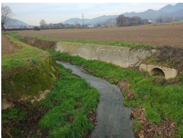
Fotografia 1: Ingresso al partitore visto verso monte
